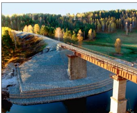
Участок Нижняя Сергинская - Михайловский завод Свердловской железной дороги (использованы габионы ООО «ЮниФенс»)
